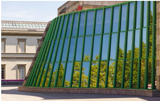
Glas mit seiner glatten Oberfläche spiegelt, wann immer der Hintergrund schwächer beleuchtet ist als der Vordergrund. Zusätzliche Beschichtungen der Fassadengläser können die Kontraste der Spiegelungen verstärken. Für Vögel vermitteln nicht nur gespiegelte Bäume, sondern auch gespiegelter Himmel freien Bewegungsraum.
