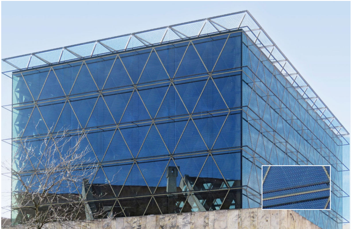
Der Glaskubus des Jüdischen Zentrums von Wandel Hofer Lorch + Hirsch in München ist umgeben von einer stählernen Stützkonstruktion und einem Bronzegewebe. Ein Dreiecksmuster aus Davidsternen sorgt durch das Spiel von Licht und Schatten im Gebetsraum für eine besondere Atmosphäre.
