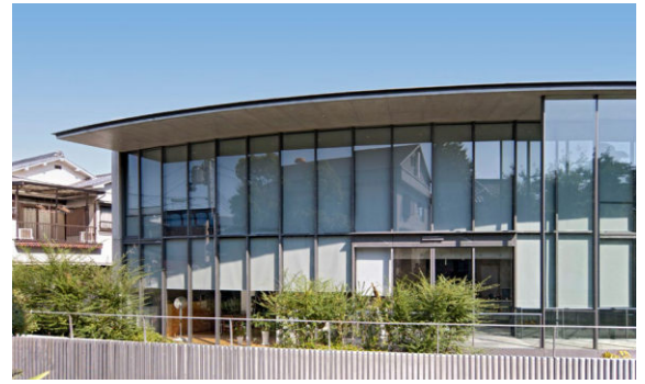
Obwohl Innenjalousien und helle Vorhänge hinter den Scheiben Reflexionen reduzieren können, kommt es häufig zu Spiegelungen. Mit einem wirksamen Schutz vor Kollisionen ist nicht zu rechnen, zumal Jalousien nicht dauerhaft heruntergelassen sind.
