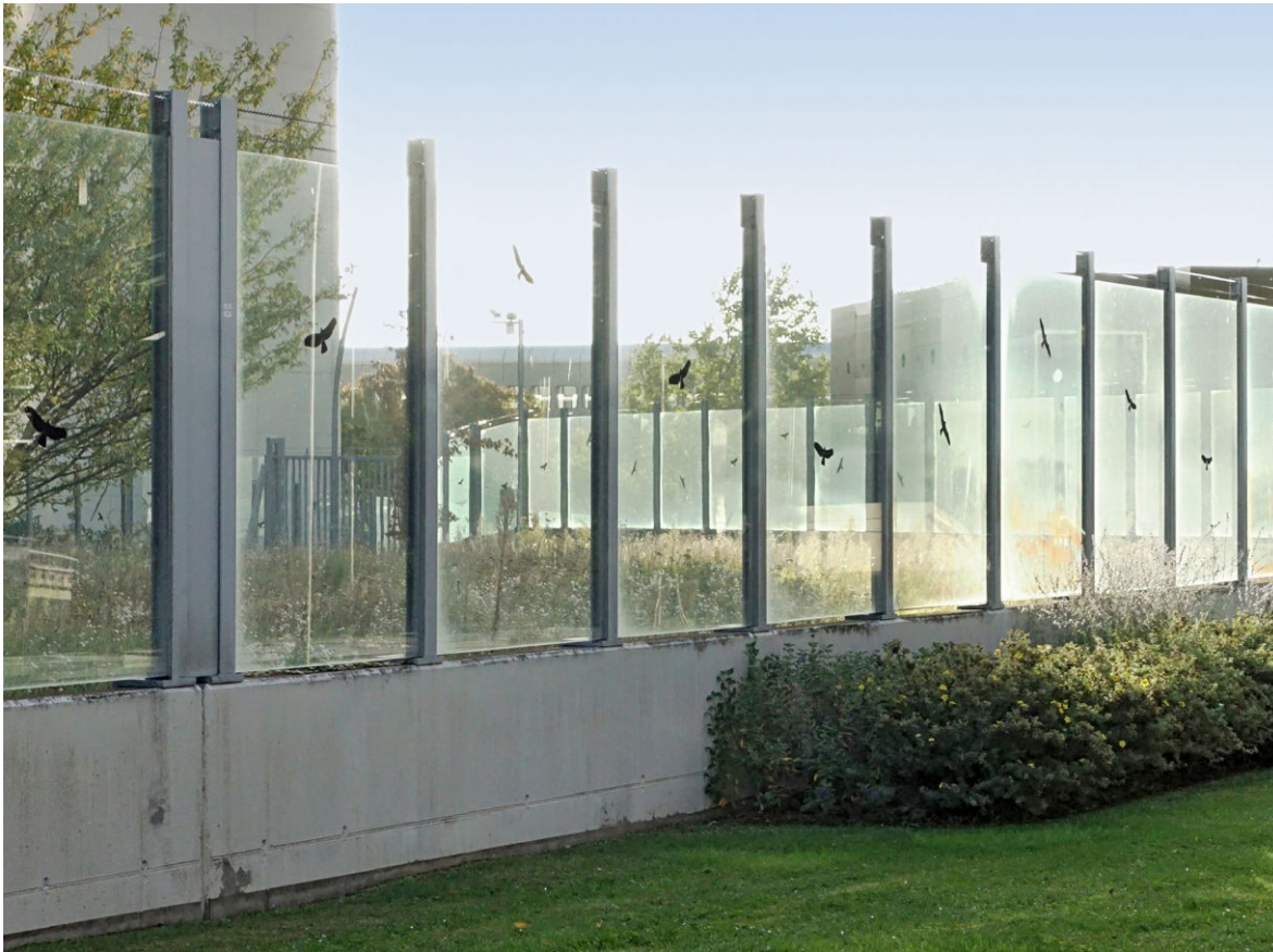
Greifvogelsilhouettenaufkleber weisen in der Regel darauf hin, dass Kollisionsprobleme bewusst geworden sind. Sie schaffen aber keinerlei Abhilfe und sollten nicht verwendet werden, da es weiterhin zu Kollisionen in unmittelbarer Nähe der Aufkleber kommt. Es sollten geprüfte Markierungen verwendet werden, welche die gesamte Glasfläche markieren.
