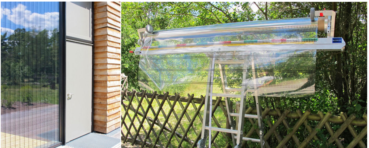
Bedruckte Folien werden vollflächig aufs Glas aufgebracht.
