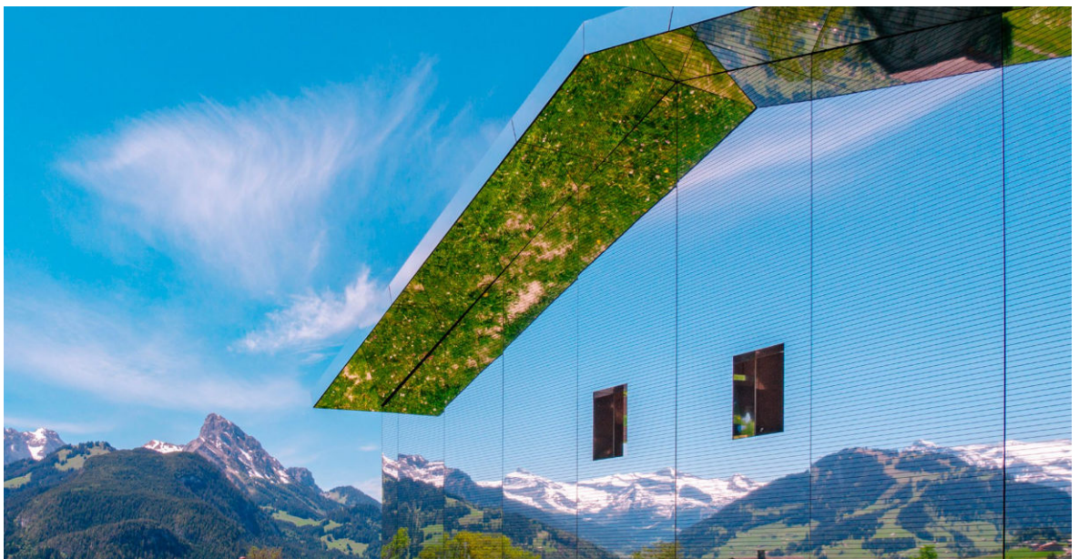
In der Kunst der Landschaftsgestaltung werden Spiegel nicht selten für spezielle Effekte verwendet, ohne dass den Kunstschaaffenden die davon ausgehende Gefahr für Vögel und andere Organismen wie Insekten bewusst ist. Die in Metall ausgeführte temporäre Installation «Mirage» von Doug Aitken in Gstaad wurde von Beginn weg mit einem Vogelschutzmuster aus schwarzen Streifen versehen.
