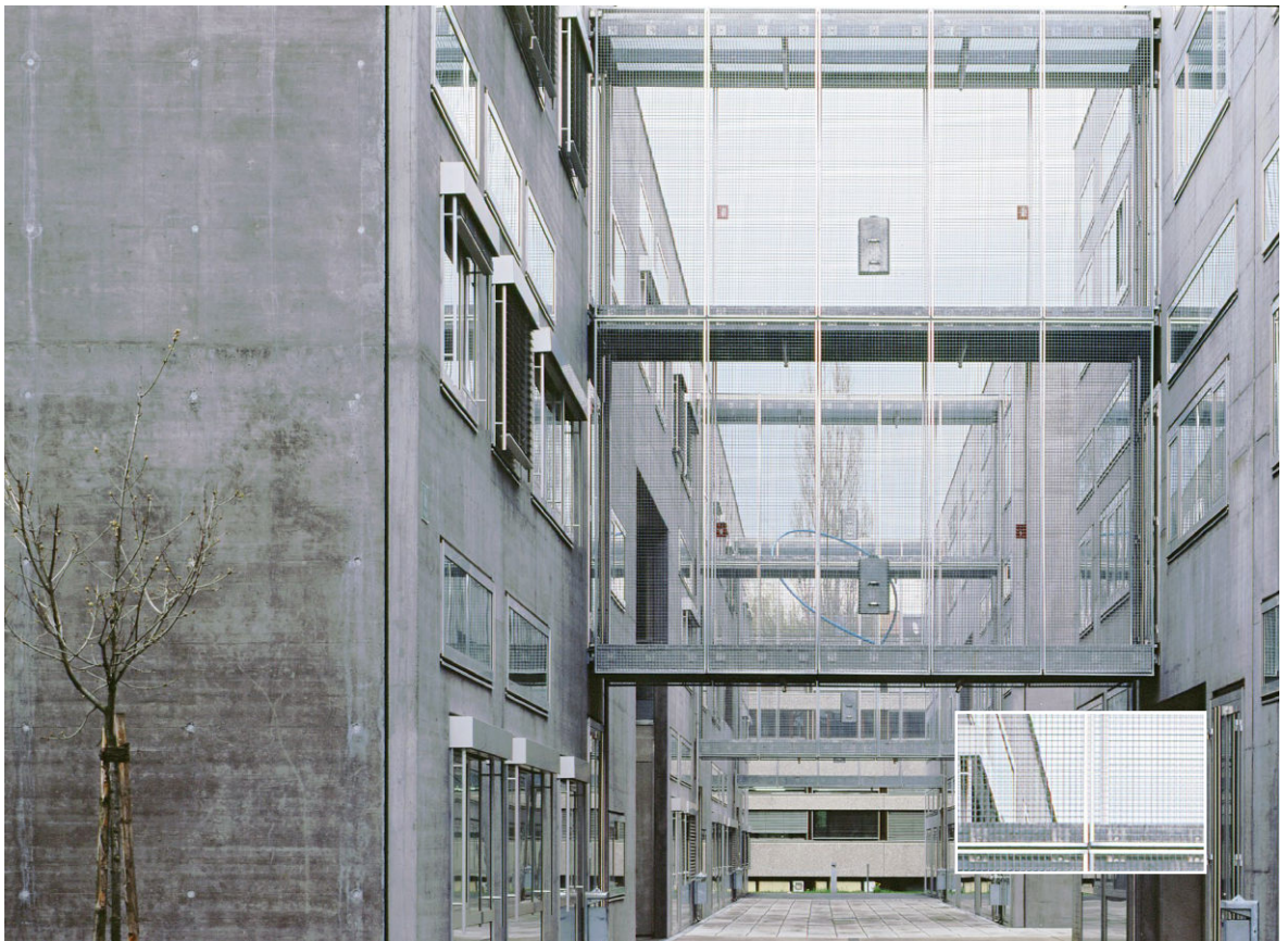
Die einzelnen Baueinheiten der Technischen Universität Graz vom Architekturbüro Riegler Riewe sind durch mehrgeschossige Brücken miteinander verbunden. Die Fassadenelemente aus Stahlgitter gewähren Durchsicht und Lichteinfall und sind für Vögel trotzdem gut als Hindernis erkennbar.
