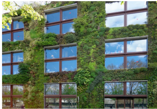
Fassadenbegrünung am Musée du Quai Branly in Paris. Solche Massnahmen zur Förderung der Artenvielfalt und zur Verbesserung des Stadtklimas müssen Hand in Hand mit Massnahmen gegen Vogelanzug gehen.
